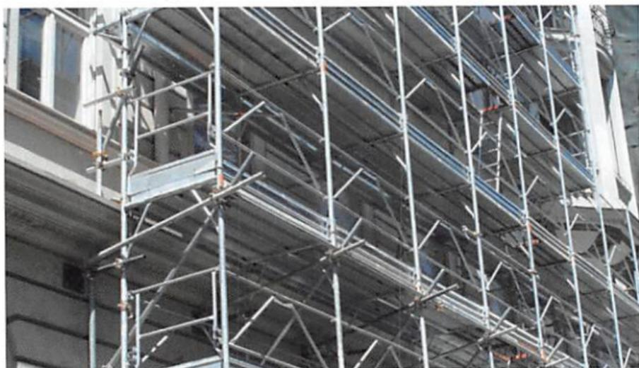
Durante il periodo di cantiere valutare anche la presenza di impalcature temporanee che potrebbe generare ombre statiche sulle superfici vetrate tali da indurre a rotture per stress termico. Anche in questo caso è possibile evitare schermando totalmente il vetro con l'utilizzo di materiale opaco, soluzione che consente anche di proteggere la superficie del vetro da danneggiamenti e contaminazioni occasionali.
