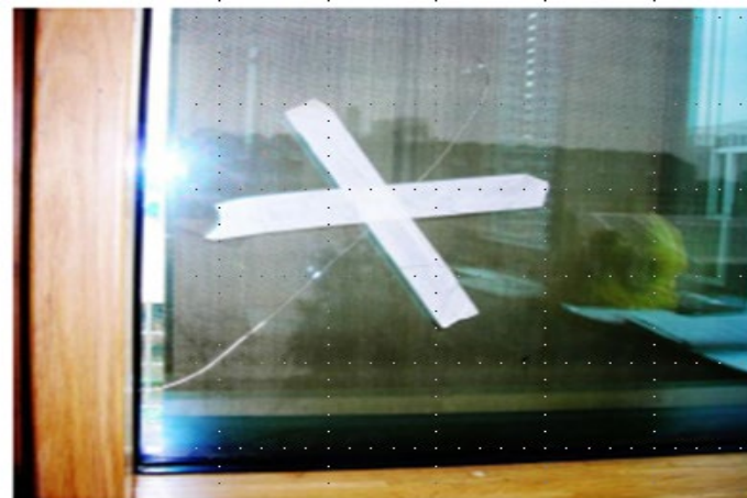
Figura 5. Rottura dovuta all'accumulo di calore in prossimità della superficie del vetro per la presenza del tendaggio interno
