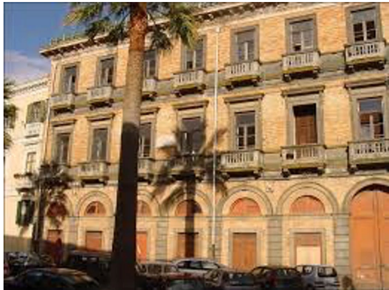
Edifici Privi di isolamento
